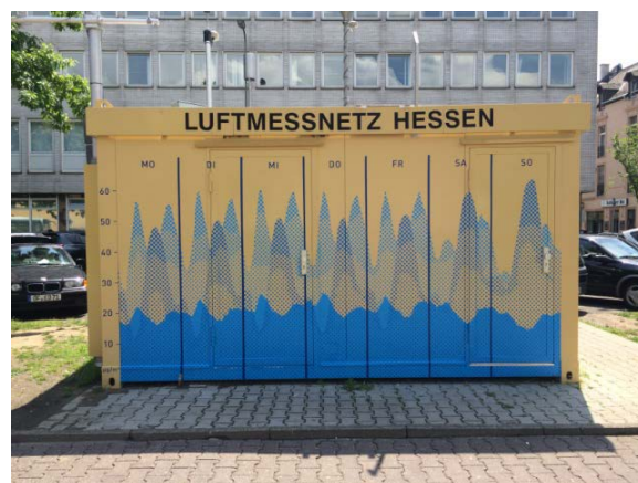
Abb. 8: Luftmessstation des städtischen Hintergrundes Höchst
