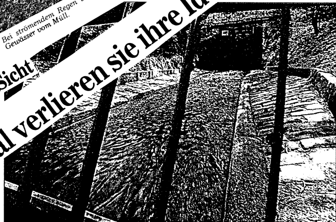
Die Drusel: Ein Korsett aus Stein und Beton raubt dem Wasserlauf seinen Charakter.
