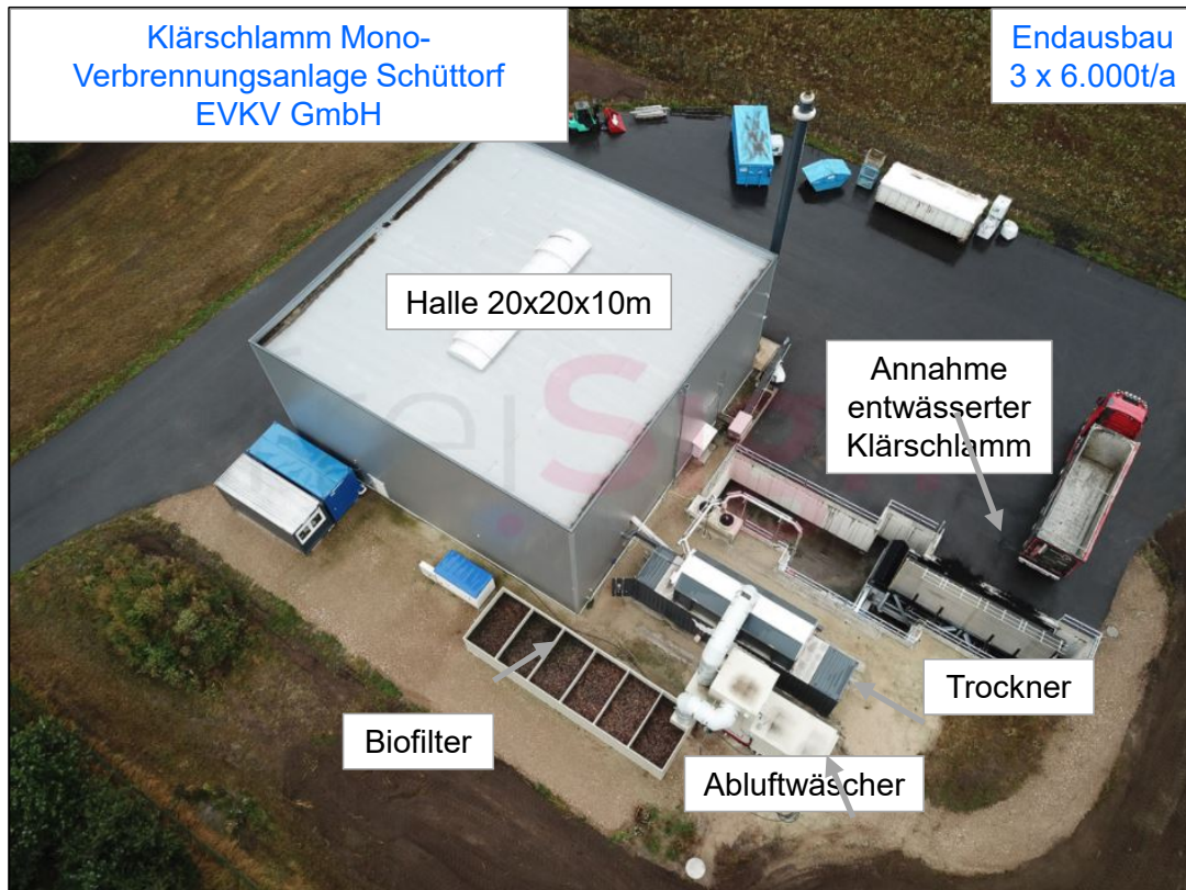
Abb. 2-2: Luftbild Klärschlammverbrennungsanlage der EVKV GmbH, Schüttorf, Foto: Werkstätten heating-systems GmbH
