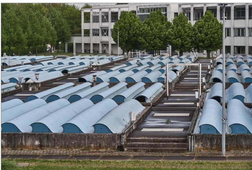
Abb. 1: Belebungsbecken mit Betriebsgebäude des Zentralklärwerks Darmstadt (Foto: ENTEGA Abwasserreinigung GmbH & Co.KG).
