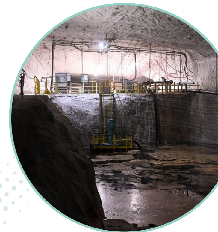
Untertägiger Zwischenspeicher für Salzabwässer in der osthessischen Grube Hattorf-Wintershall der K+S Kali GmbH
