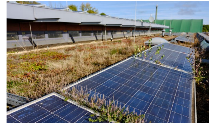
Begrünte Dächer sind eine Maßnahme für Klimaschutz und -anpassung.
